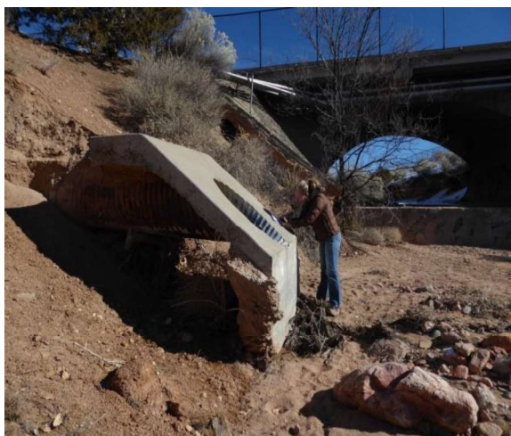
Segment D/ Bank erosion, Arroyo de los Chamisos, 2016.
