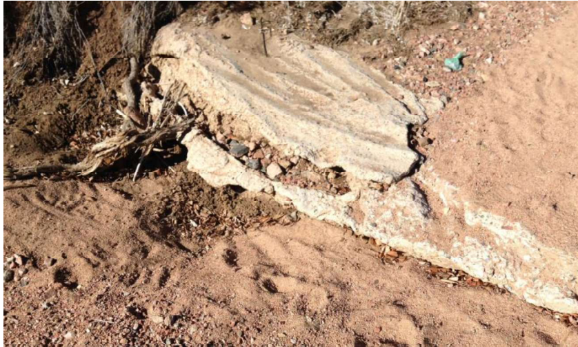
Segment C/ Encased utility line, Arroyo de los Chamisos, 2016.
