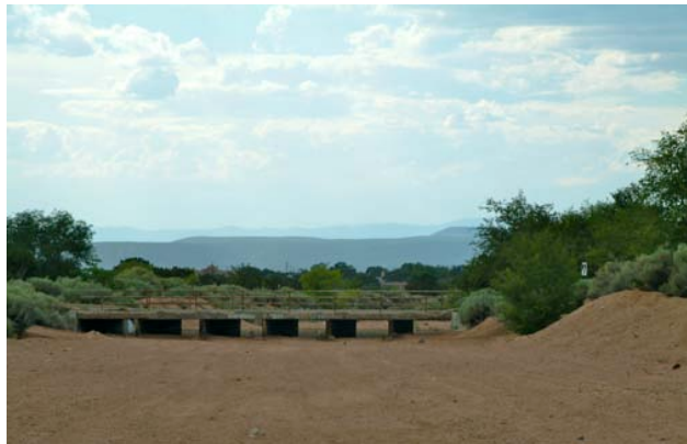
Sediment accumulation under the Ave de la Campana Bridge in the Arroyo de los Chamisos, Segment F.
